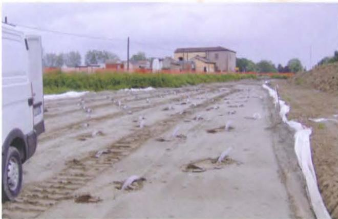
1 - Dettaglio geodreni sul piano posa rilevato
