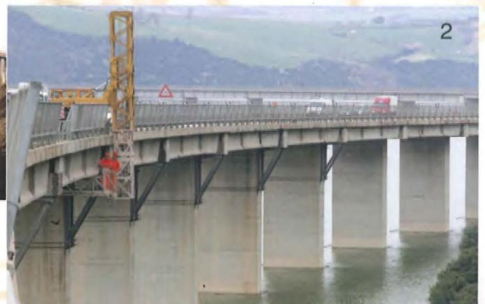
1-2) ANAS S.p.A. - Compartimento della viabilità per il Molise - Manutenzione straordinaria delle pile dei pulvini e degli impalcati - Fondovalle Biferno.
